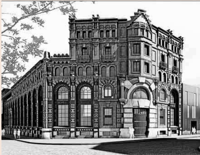
La nueva sede de Endesa en Catalunya ha conservado y ampliado el edificio modernista.
